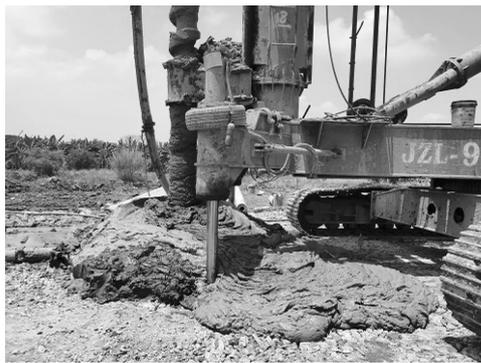
图 4 长螺旋桩周围的软土
