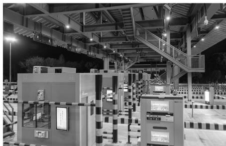
巴城收费站在出入口车道部署自助发卡机、缴费机,降低运营成本,精简人员配置,缓解收费站车辆通行压力,实现出入口无人化管理。当车辆驶进收费站时,自动发卡机受到感应后会伸出一只“机械手臂”,司机摁下取卡键后,“机械手臂”将传递出一张 cpc 卡,先感应后按键的模式进一步优化了司乘的取卡距离。
